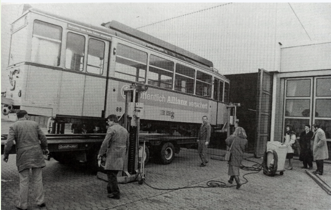
Mit einem Radgreifer wird die Tram vorsichtig vom Sattelschlepper gehoben und auf ein Hilfsgleis aufgesetzt.
